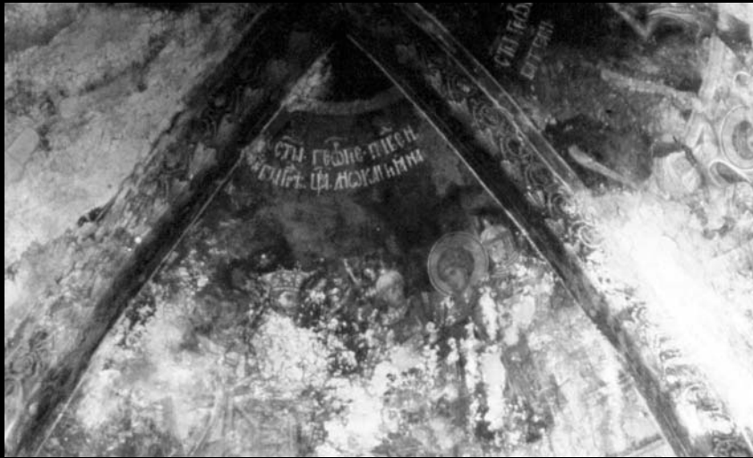
Фреске на своду цркве, карактеристична оштећења од влаге
